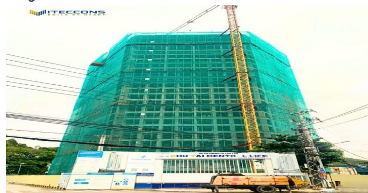
Hình 2: Dự án Phú Tài Central Life hoàn thành cốt nóc trong T12.2024.
